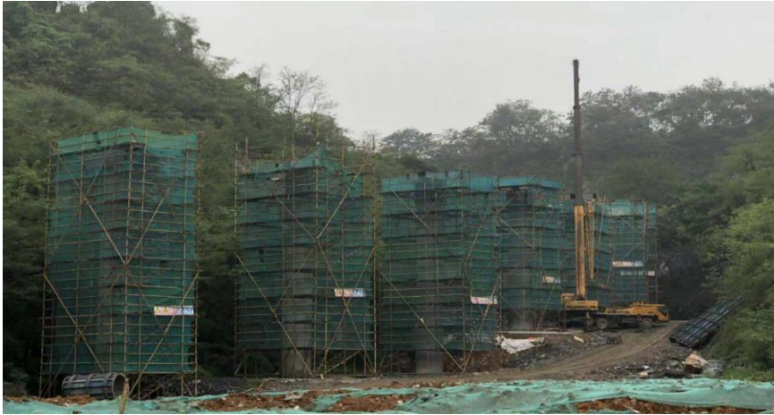
凤凰山东南部栈桥 25#、26#、27#吊装合模施工
