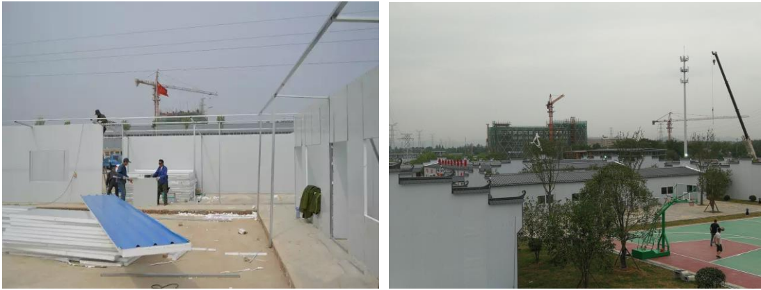
图4 主体板房施工
