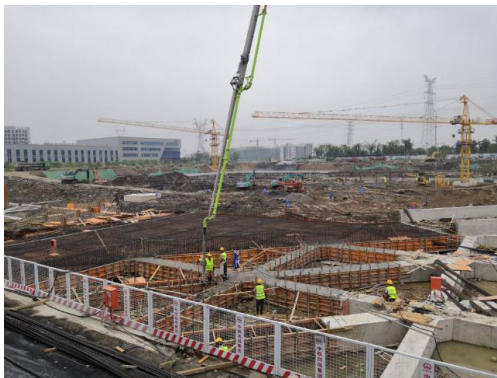
污水处理厂混凝土浇筑施工
