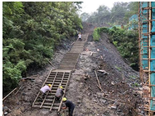
凤凰山东南部台阶支模及浇筑施工
