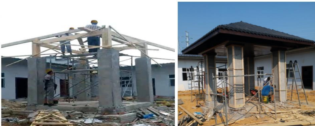
a) 景观亭安装
